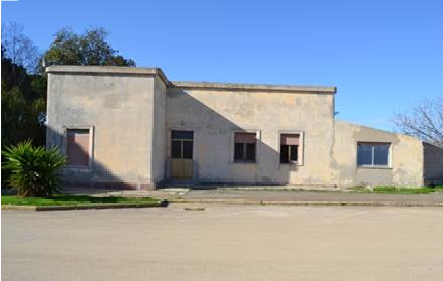
PG38_ Servizio Impianti (F.13, part. 77)
