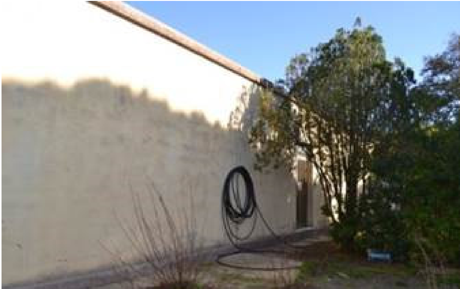
PG117_ Magazzino minuto mantenimento servizio impianti (F.13, part. 77)
