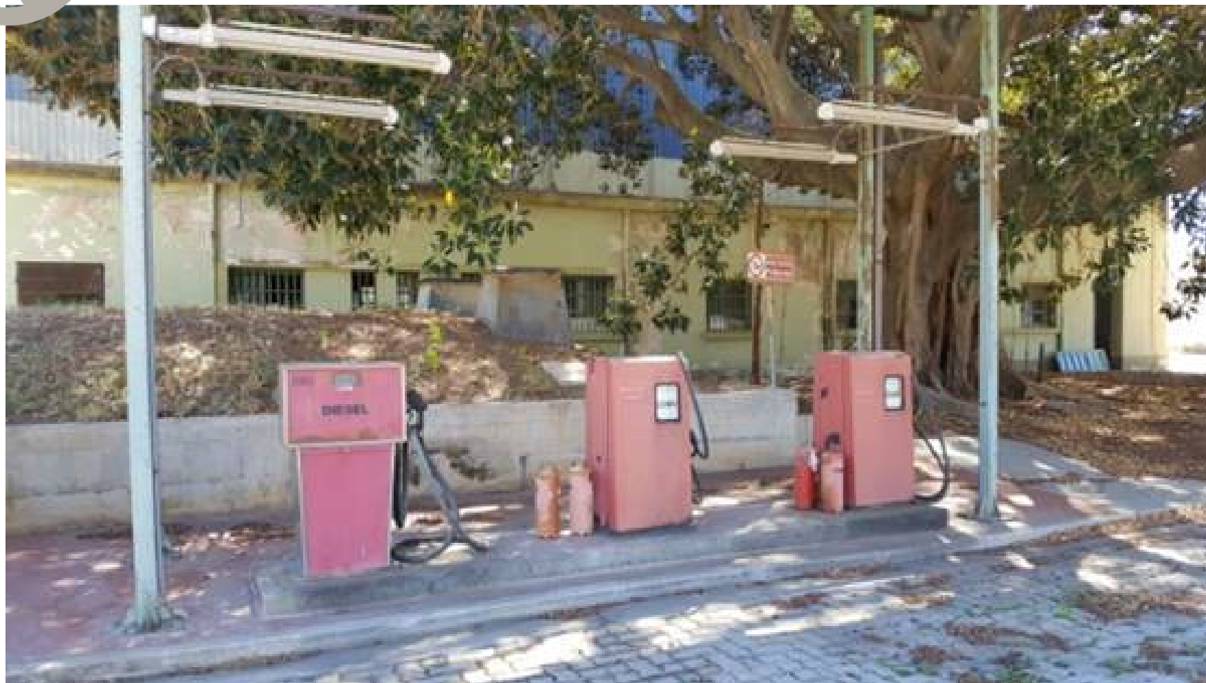
PG40_Impianto distribuzione carburante auto (NC)
