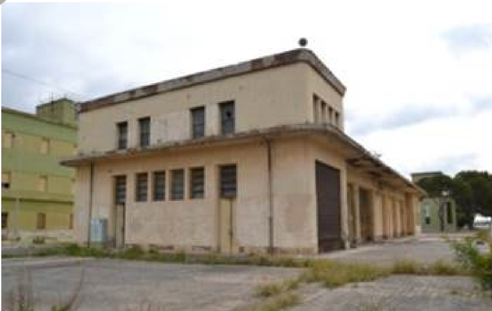
PG 10_Magazzino materiale Atlantic (F. 13, part. 93)
